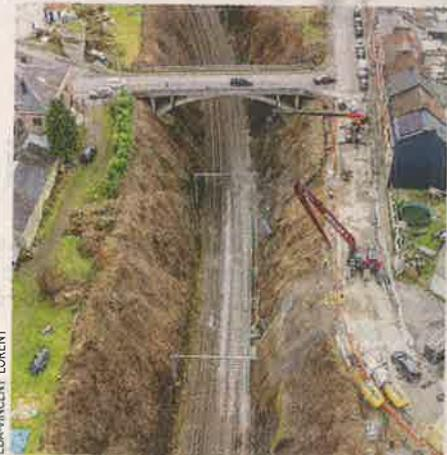
Sur ce tronçon, Infrabel a opté pour la pose d'un filet. Plus au nord, on a placé le trafic sous la protection d'un caisson.
